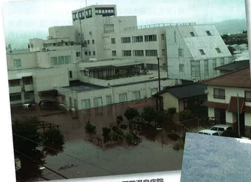
浸水被害直後の阿蘇温泉病院
